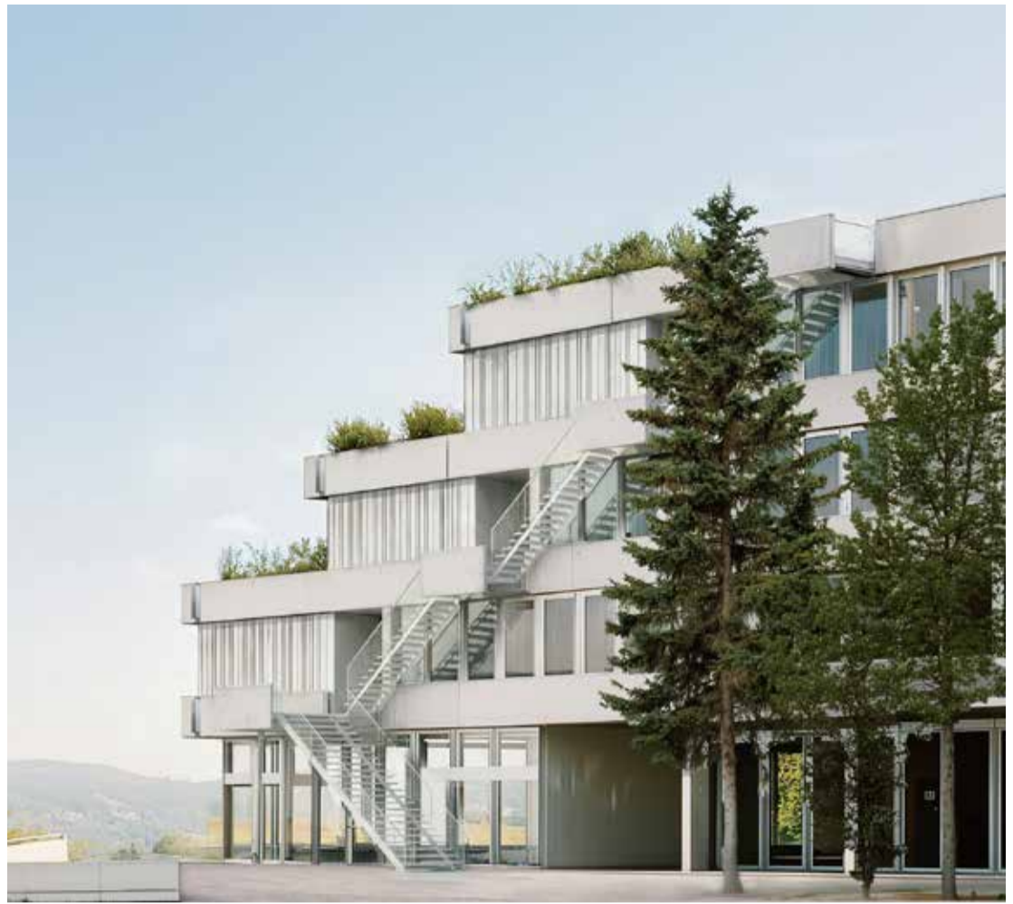
L'escalier s'aligne sur les ouvertures du bâtiment et offre une belle vue sur la ville
