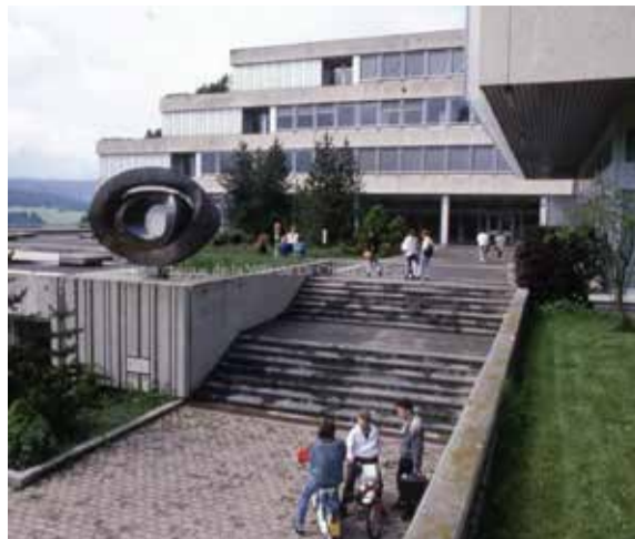
le bâtiment avant la rénovation de 1992
