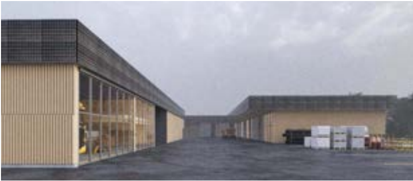
Vue depuis le stade cantonal
