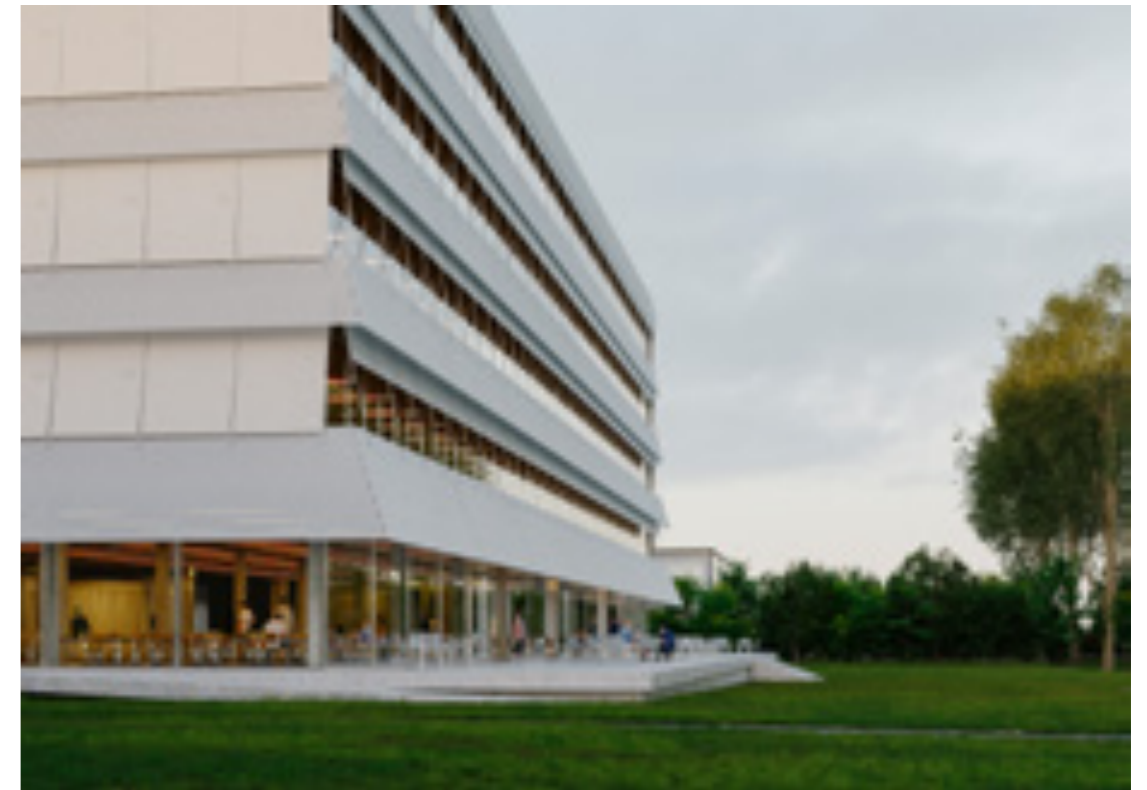
Vue du sud-ouest : voiles et bardage des façades reflètent les besoins en lumière naturelle et font écho à une architecture navale.
