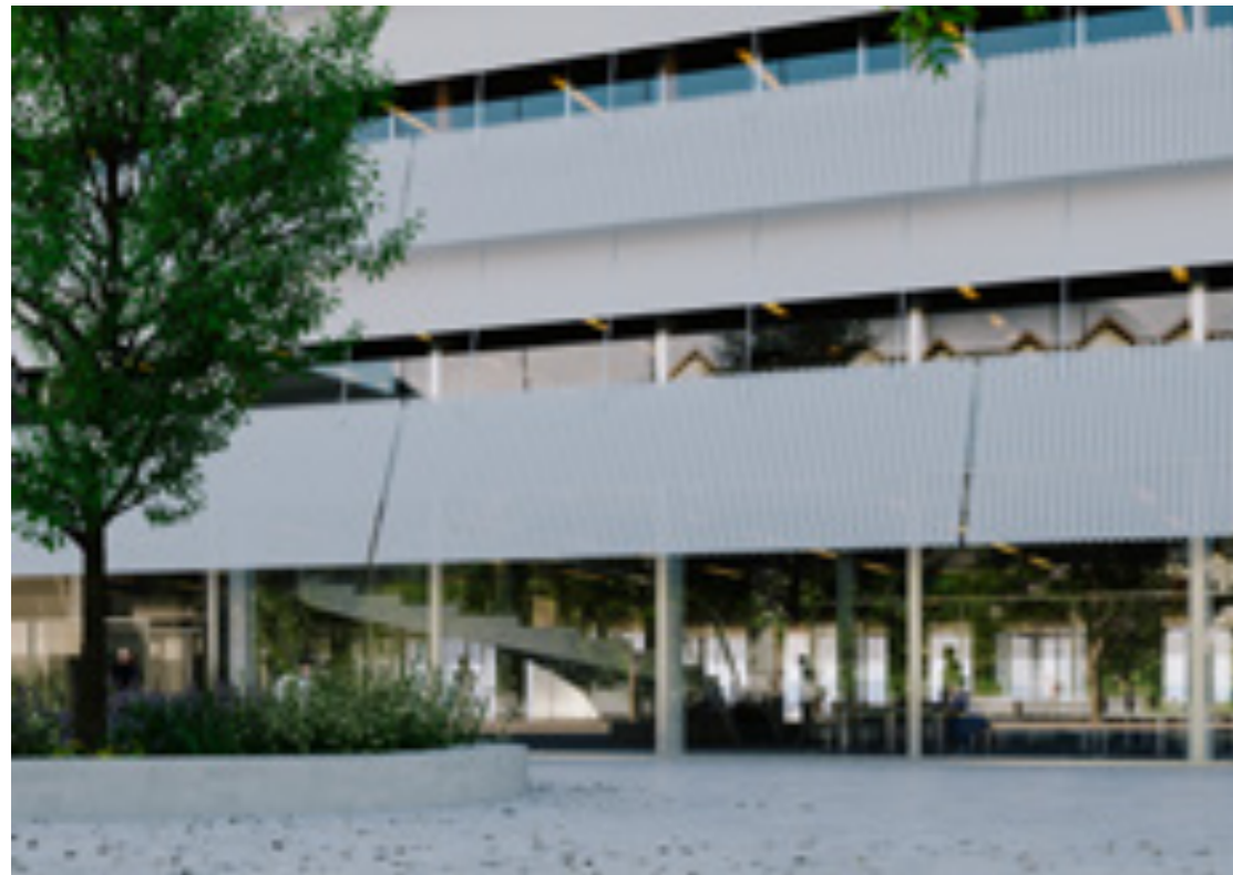
Vue du parvis : le rez-de-chaussée, fluide, s'inscrit dans le prolongement du parvis, et sa transparence en souligne le caractère public.
