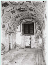
Déposé de sa fonction de « coffre-fort » et de centre des archives de l'État à partir de 1886, le local est vraisemblablement laissé à l'abandon durant quelques années. Le revêtement des murs et le décor en plâtre sont jusqu'à ce qu'une restauration leur redonne du lustre à la fin des années 1920. (IOPAN, fonds ISCP n°2743 et n°2744)
