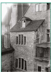
Difficile à percevoir aujourd'hui comme un espace d'agrément, la loggia aménagée au 15 e siècle par Marie de Savoie et Philippe de Hochberg, s'ouvrait sur une petite cour et jouissait d'une vue qui n'était pas obstruée par les bâtiments qui ferment aujourd'hui cette cour. (IOPAN, fonds ISCP n°371).
