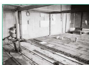
Au début du 20 e siècle, la coexistence d'une technologie contemporaine avec la conservation des éléments anciens est à l'ordre du jour, à l'image de la nouvelle dalle en béton armé coulée dans la salle des Chevaliers en 1925 ou des distributeurs de chauffage au sol posés en 1934 dans la galerie Philippe-de-Hochberg. (OPAN, fonds ISCP n°3052 et n°3480)
