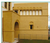
L'entrée de l'aula et la façade de la camera. (OPMAN, photo Patrick Jegg 2010)
