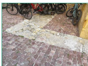
Insérer un bâtiment de la taille de la salle du Grand Conseil entre le Château et la Collégiale et lui assurer un éclairage naturel suffisant conduisent les architectes du 19 e siècle à sacrifier une partie de la tour nord du portail. (OPAN, 2023)
