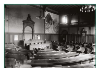
Vue de l'hémicycle en 1912. Le mur nord est aveugle, permettant l'installation du bureau de la présidence, ainsi que de l'œuvre monumentale de Girardet dès 1898. (OPAN fonds ISCP n°410)
