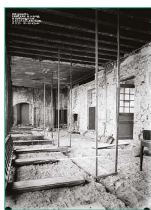
Revenir à un état initial est parfois utopique, comme le montrant en 1932 le volume de la galerie délogé de ses cloisons et, en 1933, les gabarits rappelant l'emplacement initial du mur nord. (OPAN, fonds ISCP n°3988 et n°4204)
