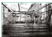
Au début du 20 e siècle, la coexistence d'une technologie contemporaine avec la conservation des éléments anciens est à l'ordre du jour, à l'image de la nouvelle dalle en béton armé coulée dans la salle des Chevaliers en 1925 ou des distributeurs de chauffage au sol posés en 1934 dans la galerie Philippe-de-Hochberg. (OPAN, fonds ISCP n°3052 et n°3480)
